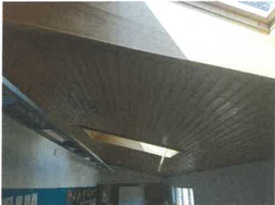
Dachfläche Flur DG
