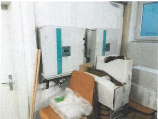
Wechselrichter PV-Anlage
