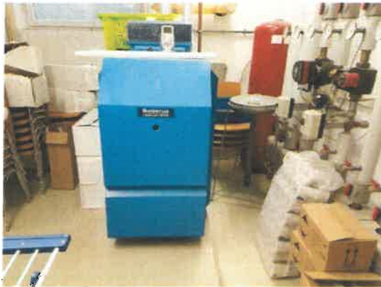
Gasbrennwert-Kessel
