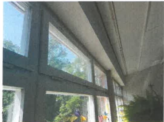
Verglasung Klassenzimmer DG
