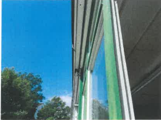
Sonnenschutz Klassenzimmer EG
