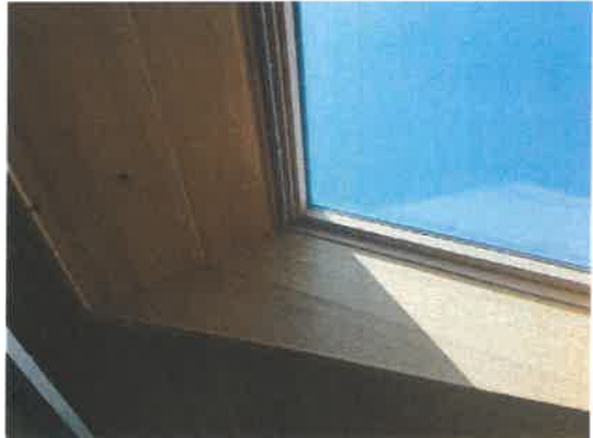
Dachflächenfenster Flur DG
