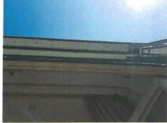
Sonnenschutz Klassenzimmer EG
